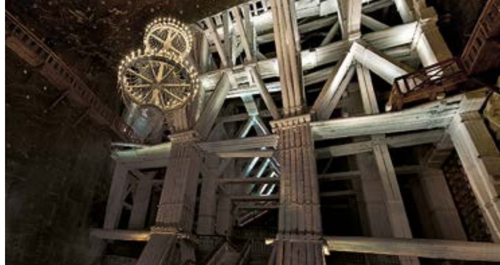
DREWNIANA KONSTRUKCJA ZABEZPIEZAJĄCA WNĘTRZE KOMORY MICHAŁOWICE, KOPALNIA SOLI W WIELICZCE © A. NOWAKOWSKI, KSW
