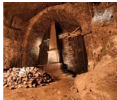
XIX-WIECZNA KOMORA FRANCISZEK KAROL POŁOŻONA NA NIŻSZYM POZIOMIE II JEST JEDNĄ Z NAJWIĘKSZYCH KOMÓR W KOPALNI. KOMORA LEŻY POZA OBECNĄ TRASĄ TURYSTYCZNĄ ZE WZGLĘDU NA ZŁY STAN TECHNICZNY. OBECNIE TRWAJĄ W NIEJ PRACE KONSERWATORSKIE.
